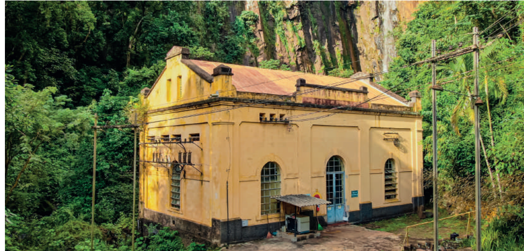
Antiga Usina Hidrelétrica de São Valentim, uma das mais antigas do estado, localizada no vale da cachoeira São Valentim, de 75 metros de altura
