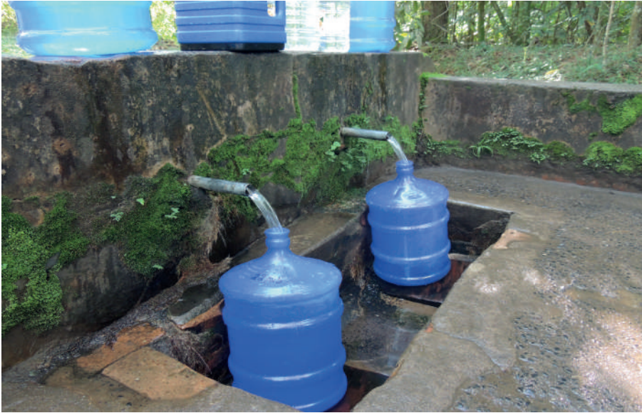
1 - Captação de água superficial do afluente do córrego Passa Quatro, no Horto Florestal (ver página 65).
