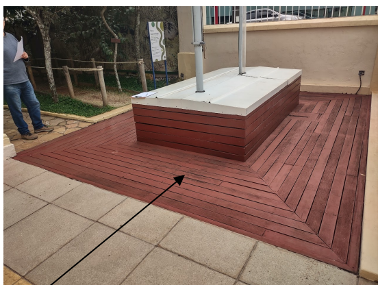
Piso de madeira a ser demolido
